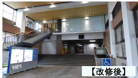
写真一 正面玄関の特定天井の改修
